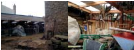
Vues du hangar à outils
