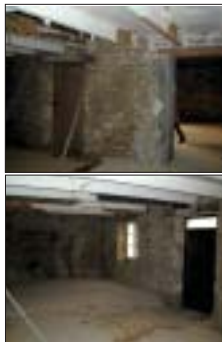
Vue intérieure chantier maison principale
