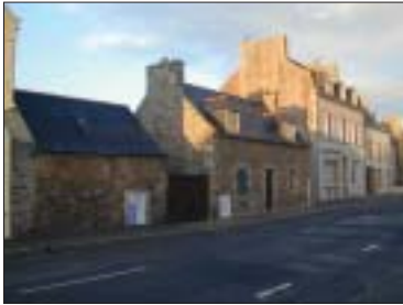
Façade rue maison principale et remise
